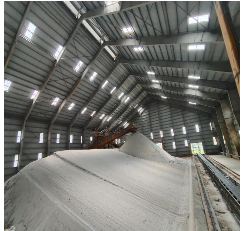
Slag & Gypsum Storage inside
